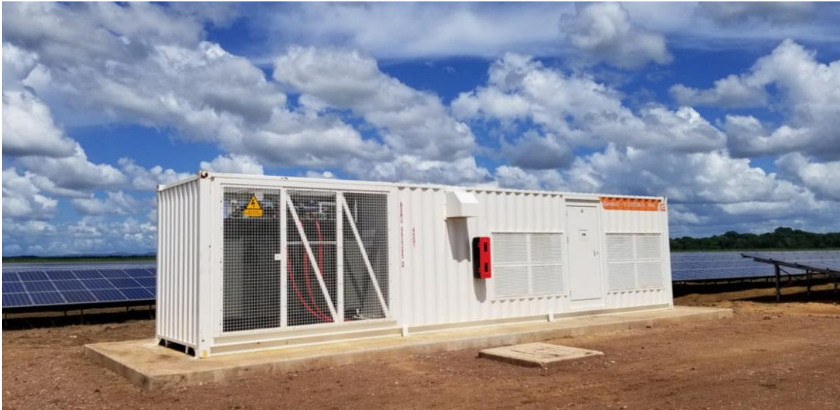
Slika 8. Primjer izmjenjivača, Gamesa Electric PV Station 5000; Izvor: www.gamesaelectric.com - Idejno rješenje SUNČANA ELEKTRANA BUMES-VRLIKA (1,2 MWp), Broj projekta: 01/02-2022, Izrađivač: EnergoVizija d.o.o., svibanj 2022.
